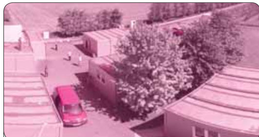
▲ پژوهش میدانی: در روتته در نزدیکی هانوفر، GEO۶۰۰ هر دو بازوی ۶۰۰ متری خود را گشوده است. قلب آن ساختمانی در مرکز است که دستگاه لیزر (نزدیک، سمت چپ) در آن قرار دارد.
